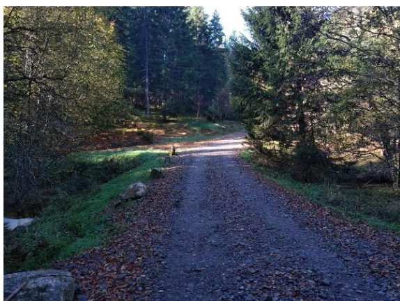
Figure 2: Vue de la piste forestière au-dessus de l'ouvrage
