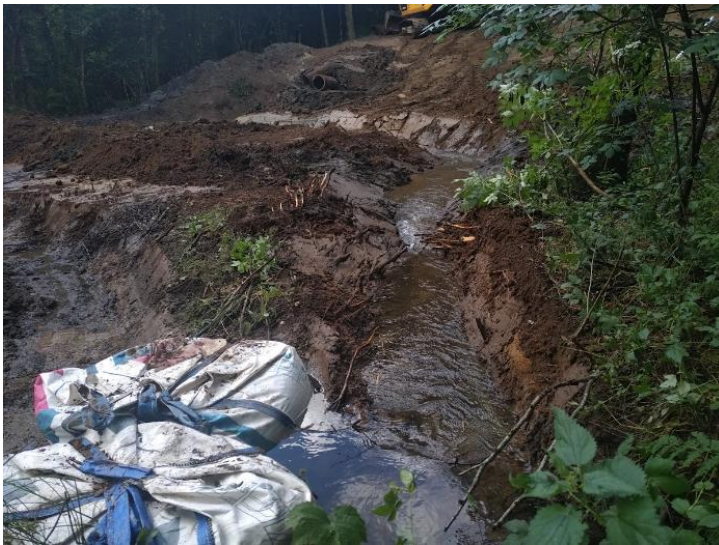
Figure 5 : Exemple de batardeau confectionner à l'aide de sacs de sable
