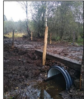
Exemple de ponceau demi-buse PEHD
