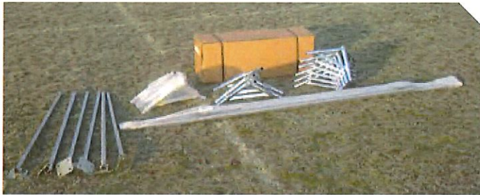
Placer les éléments d'armature au sol
