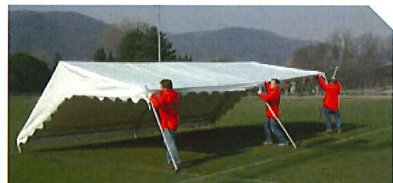
Soulever d'abord un côté de la tente et mettre les pieds et ensuite l'autre côté.
